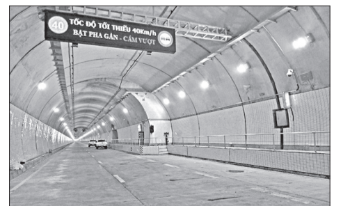
Hầm Hải Vân 2 phục vụ phương tiện di chuyển từ Đà Nẵng đến Thừa Thiên - Huế, hầm Hải Vân 1 lưu thông chiều ngược lại.
